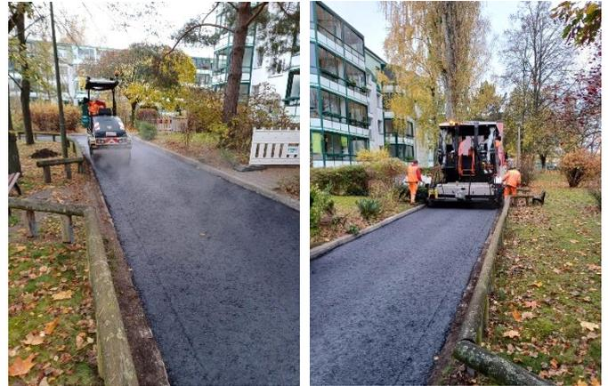
Und am 6. November 2024 war es dann tatsächlich so weit. Innerhalb von zwei Tagen war die alte Betondecke abgefräst und der neue Asphalt aufgebracht. Die kurzfristigen Einschränkungen für die Mieter waren gering und das Ergebnis überzeugt sicher nicht nur uns. Die Unfallquellen durch den aufgeplatzten Beton sind nun Vergangenheit und wir sind froh, dass die Arbeiten noch vor dem Wintereinbruch geschafft wurden.
