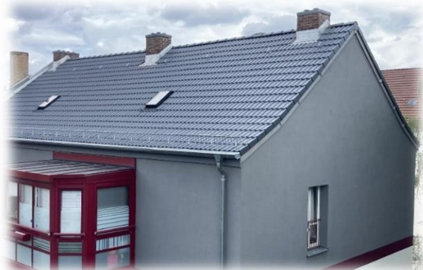
Dach nach Neudeckung
